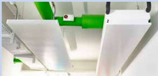
SMARTLINE-Segel (li.) und COOLLINE- Kühlkonvektor (re.)
