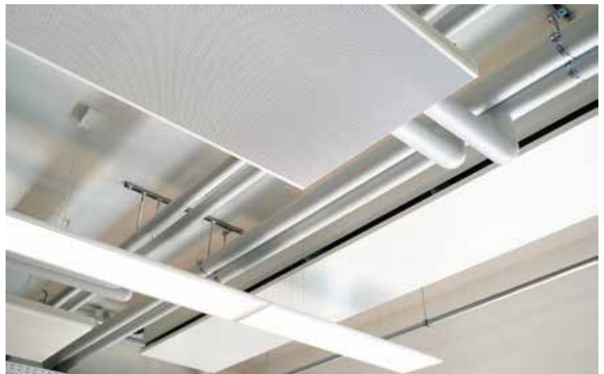
SMARTLINE-Segel (vorne, oben) und COOLLINE-Kühlkonvektor (hinten re.)
