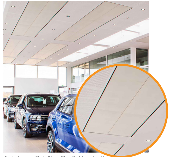
Autohaus Schütz, Groß-Umstadt Heiz-, Kühl- & Akustiksegel Typ SMARTLINE
