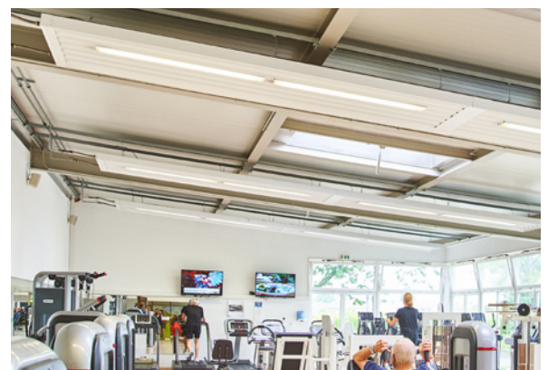
SGA Fitnessraum, Darmstadt Deckenstrahlplatten ECO EVO Plus perforiert, mit integrierter LED-Beleuchtung
